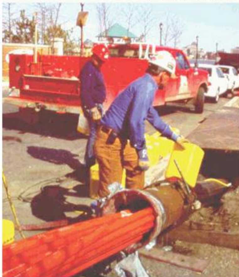
7.12-СУРЕТ Талшықты-оптикалық кабельдер орамын төсеу (Компьютер Лэнгвич Ко.Икн. беруі бойынша).
